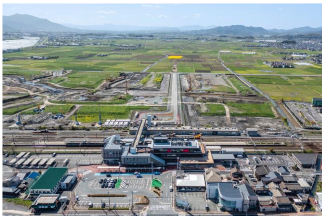
JR 遠賀川駅周辺
