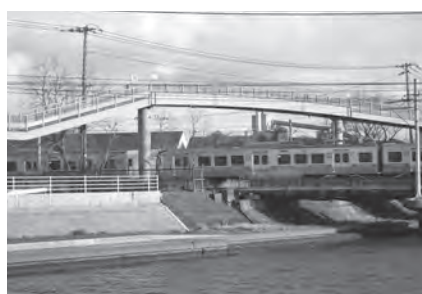
撤去予定のあけぼの歩道橋
