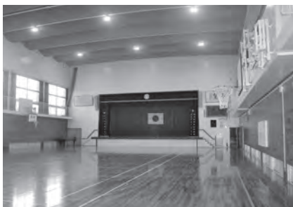
空調設備が待たれる体育館
