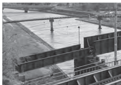
撤去予定の旧室木線鉄橋と水管橋
