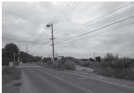
工事が行われる千代丸の交差点部分
