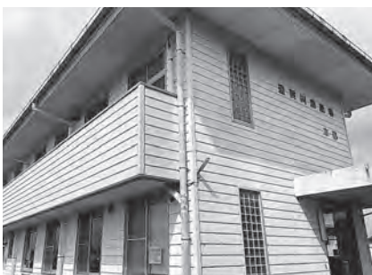
建設から39年経過した漕艇場の宿泊棟
