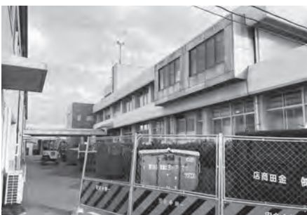
2階化工事が始まった庁舎
