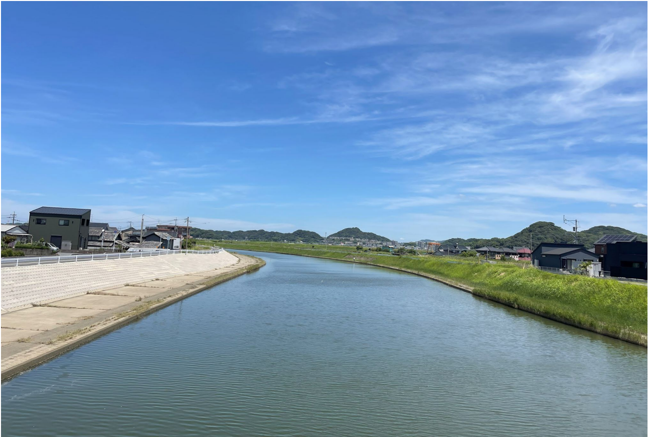
◆西川(下流方向:県道 286 号黒山広渡線橋りょうより)
