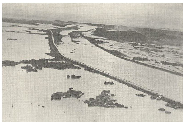
◆浸水した遠賀村(老良付近 昭和 28 年)
