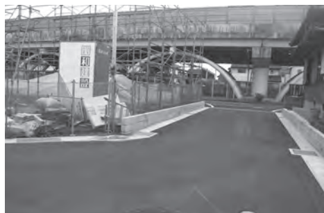
認定された町道少田12号線(遠賀川3丁目)
