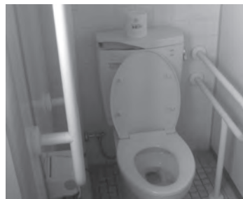
遠賀中学校第一体育館トイレ
