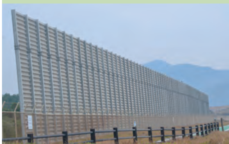
建設中の防潮柵
