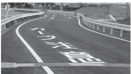
横断側溝が追加された「老良・上別府線」
