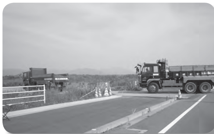
縮小した施工予定地に搬入され る盛土土砂
