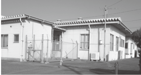
避難場所に整備される旧給食センター
