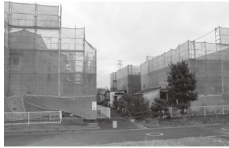
改修工事が進む道官団地
