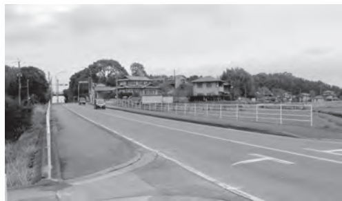
街灯の設置が望まれる県道宮田・遠賀線
