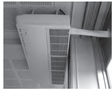
学校に設置予定の空調機
