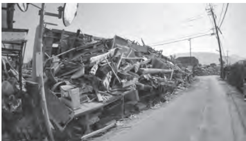
熊本県益城町の災害の様子
