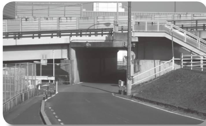
危険な国道3号線下道路、 拡幅が望まれる
