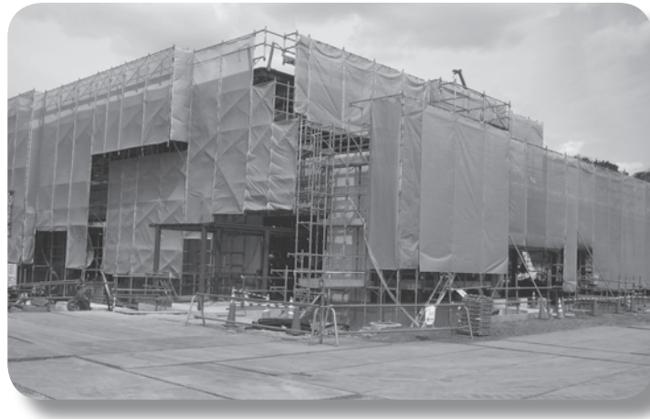
公契約で建設が進む 食育交流・防災センター
