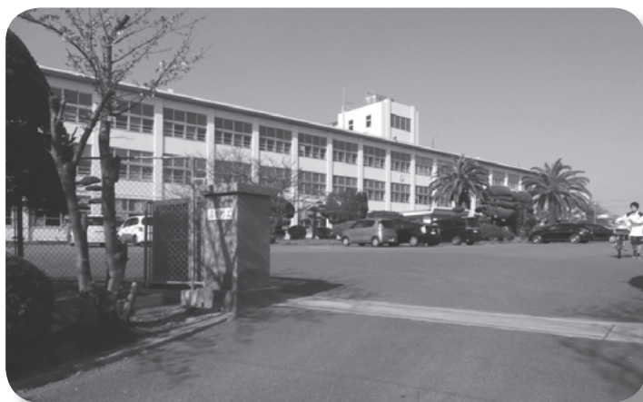
空調設備設置が待たれる学校
