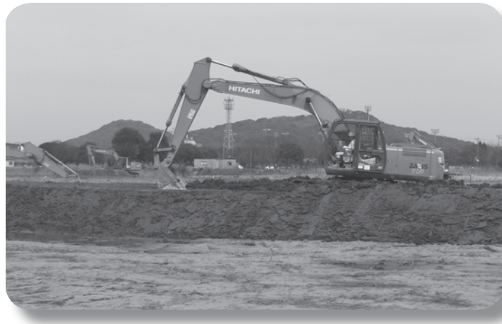
再開された浚渫土の搬入
