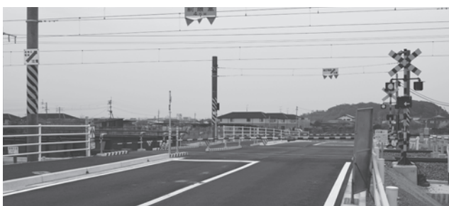
工事が進む白毛踏切道
