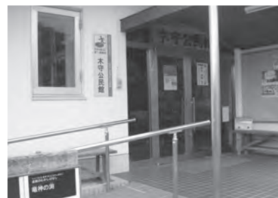
改修工事予定の木守公民館
