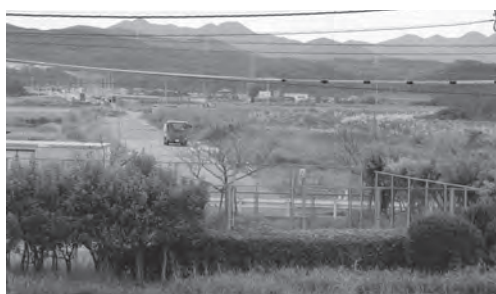
1工区との接続が待たれる2工区
