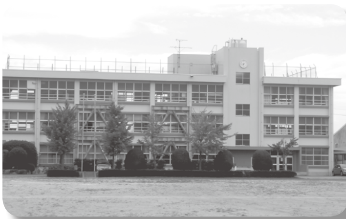
平成29年度エアコン設置予定 の広渡小学校
