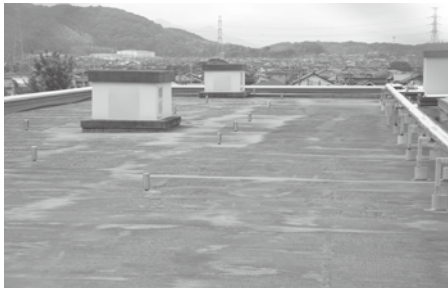
太陽光パネルが設置される広渡小学校屋上
