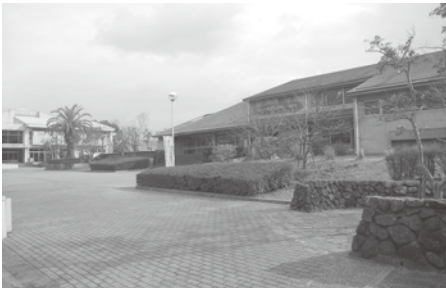
改修工事を行う遠賀コミュニティセンター
