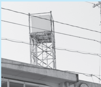
腐食が激しい貯水槽
