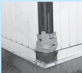
仮補修されたシャッター倉庫
