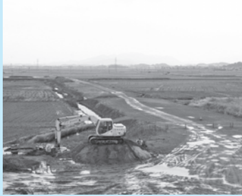
駅南側駐車場付近
