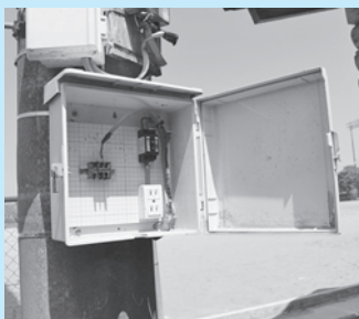
旧式の屋外音響設備配電盤
