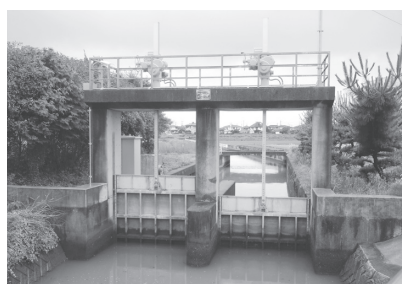
カメラを設置する平田川井堰
