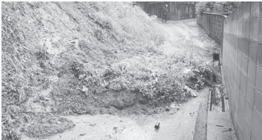
土砂崩れ箇所（虫生津町宮住宅付近）
