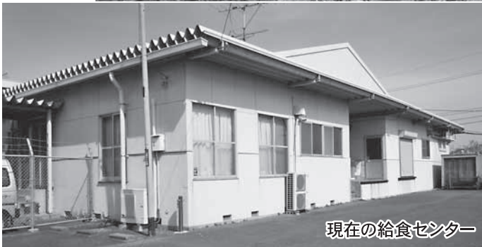
食育交流・防災センター建設予定地 (遠賀南中学校北側)
