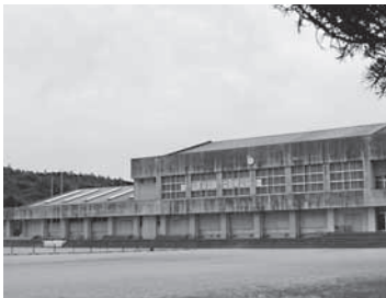
遠賀南中学校屋内運動場
