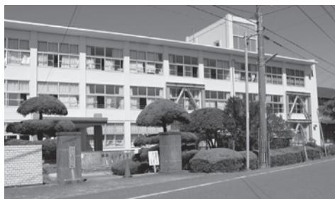
フェンスが設置される島門小学校
