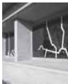
破損したガラス
