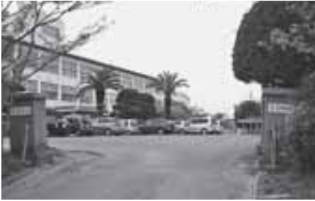
門扉を設置する遠賀中学校
