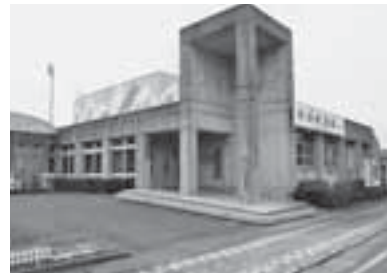
改修工事が行われる田園公民館
