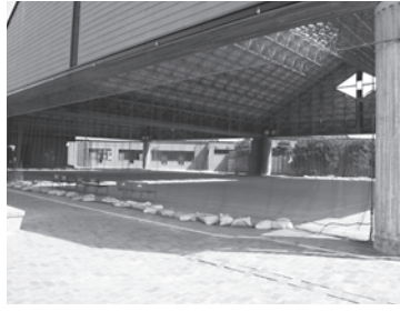
改修される屋内運動場
