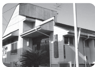
▲改修が待たれる新町公民館
