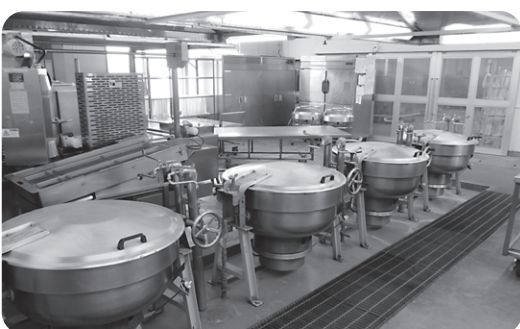
▲定期的に点検整備が行われている給食センター
