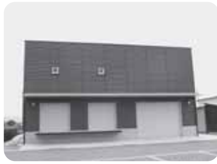
▲役場北側に建築された備蓄倉庫
