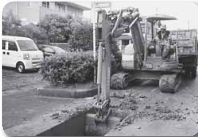
下水道工事における 開削工法の状況
