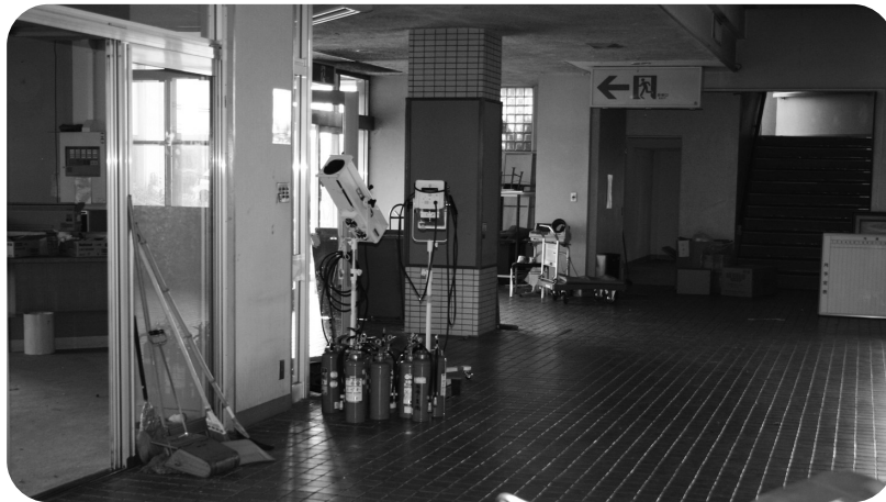
改修を待つ中央公民館
