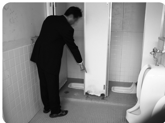
▲改修を行う和式トイレ
