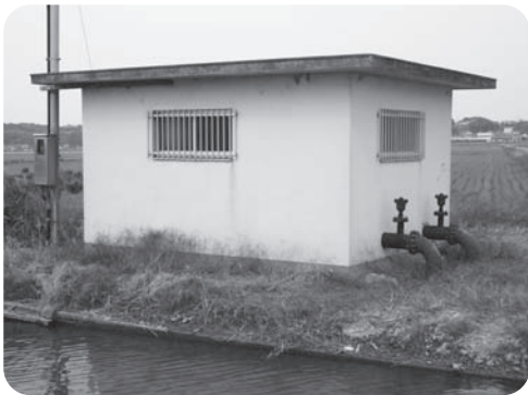
▲鬼津ポンプ施設
