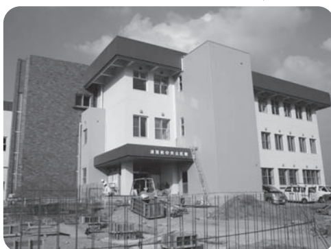
▲改修工事中の中央公民館
