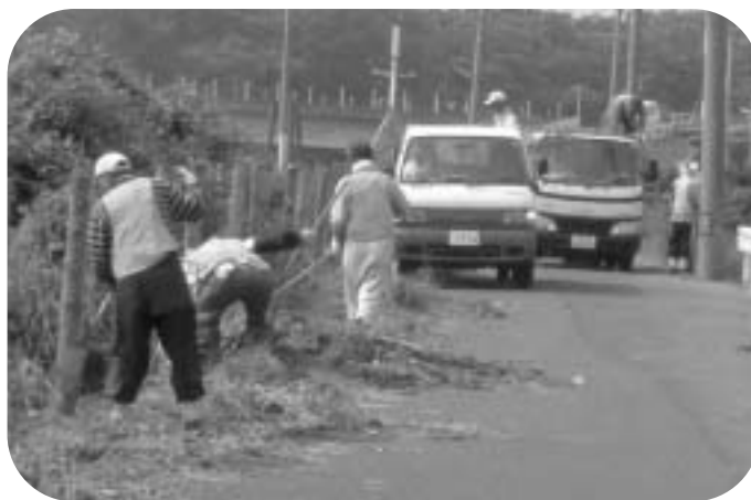
草刈作業現場
