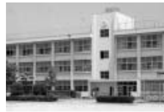
アスベスト除去工事
