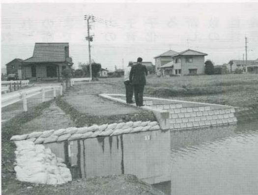
蓮角川にかかる橋梁
