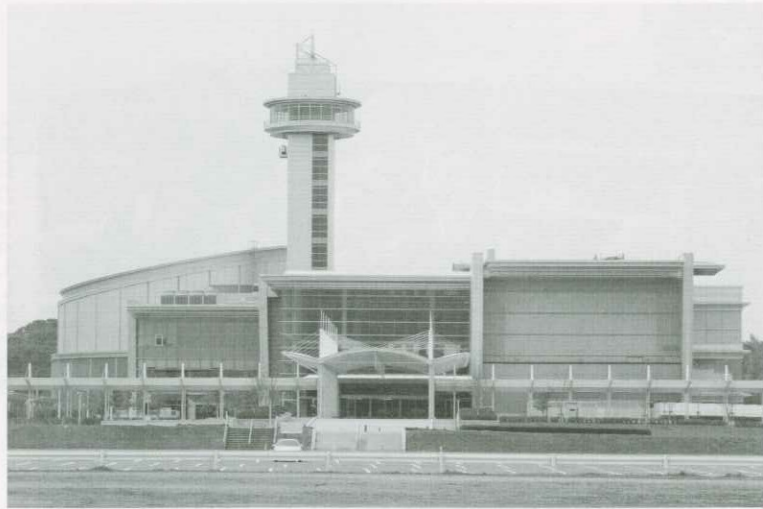
リニューアルされた芦屋競艇場
