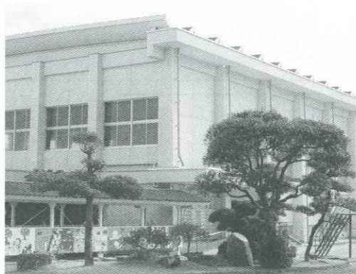
大規模改修が行われた浅木小学校体育館
