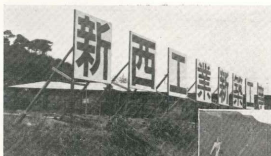
建設中の新西工業
