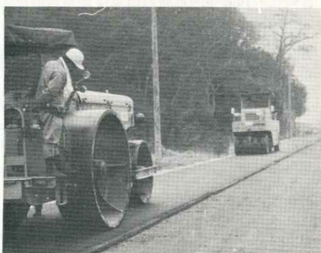
山手線道路舗装工事の状況
