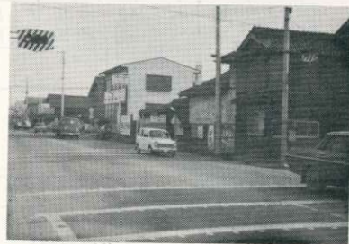
国道3号線 駅前 横断歩道及び信号機
