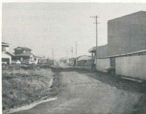
駅前団地内(新町)道路進捗状況
