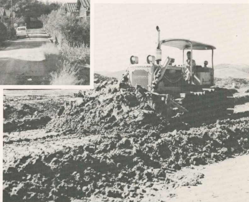
浅木団地造成工事
