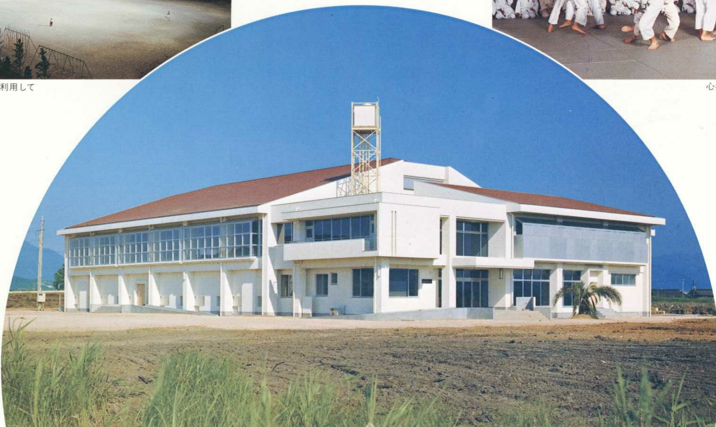
室内スポーツの盛んな遠賀勤労者体育センター
