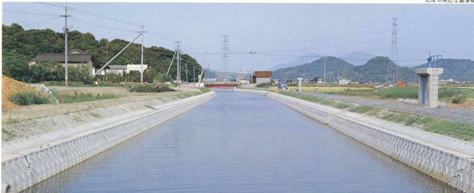
水の流れも美しく…河川改修
