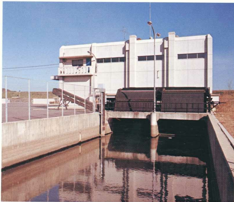
農業施設の充実…排水機場
