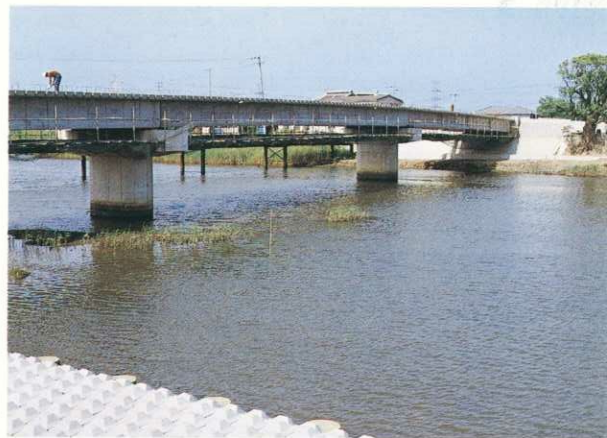
完成も間近な島津橋
