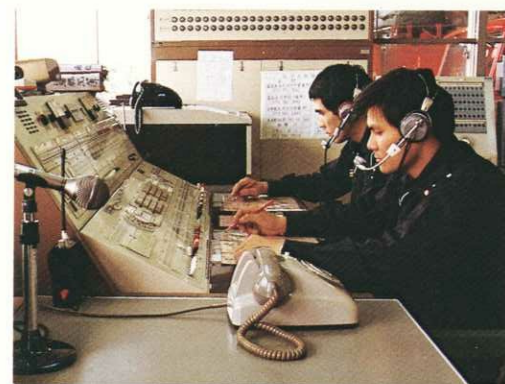
防災の中枢 消防指令室
