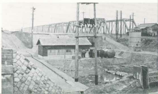
遠賀村簡易水道浄水場
