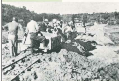
山手線道路改良工事風景
