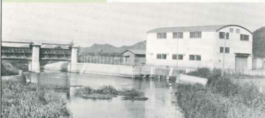
西川湛水防除事業広渡排水機場
