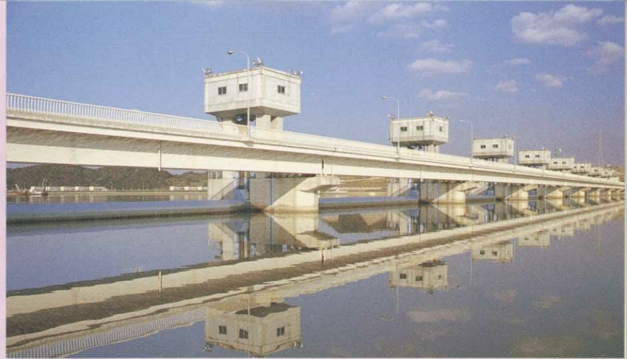
昭和55年3月 遠賀川河口堰(49年4月着工)完成
