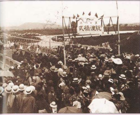
大正13年 遠賀川橋完成
