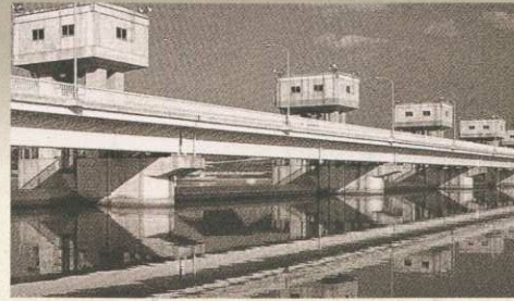
昭和49年4月に着工した遠賀川河口堰が、昭和55年ついに完成。人々の暮らしに安心と潤いをもたらした。
