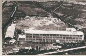
昭和40年に落成した島門小学校防音校舎。
