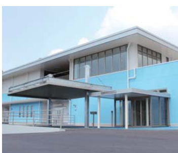
食育交流・防災センターには備蓄倉庫を整備し、非常用物資を確保。
