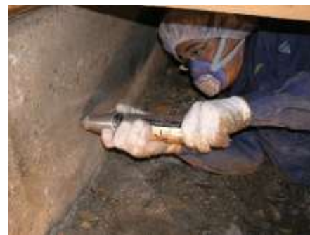
写真：(左)小屋裏調査、(右)基礎強度調査
