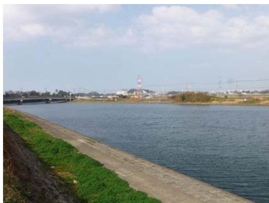
■西川下流域(平成 28 年度) 不法係留プレジャーボートはほとんど片付いている。
