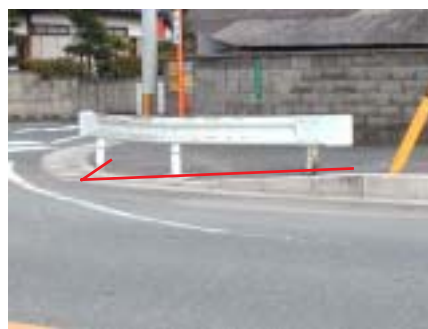
車道とのすりつけ部
