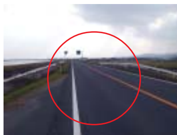
歩道が無い区間
