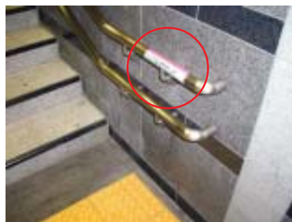
手すりの点字表示の例
