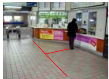
主要な経路に視覚障害者誘導用ブロックが設置されていない
