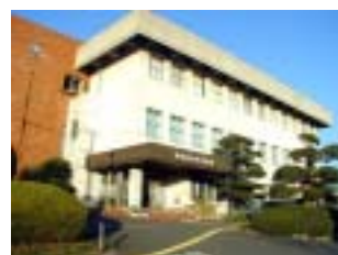
遠賀町中央公民館
