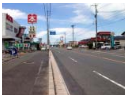
アスファルト舗装
