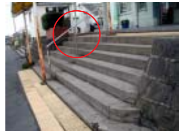
階段の中央にのみ手すりがある
