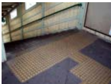
階段には視覚障害者誘導用ブロックが設置されている
