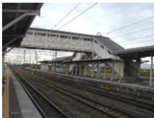
JR 遠賀川駅 (ホーム)
