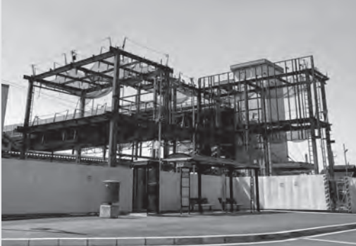
新遠賀川駅舎鉄骨工事
