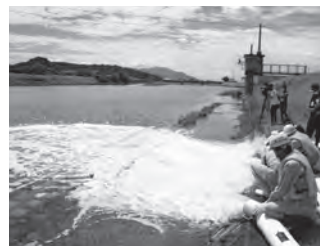
▲排水中の様子
