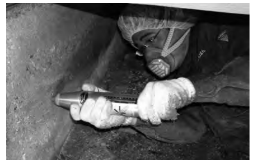
床下に潜り基礎強度を測定
