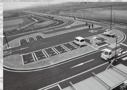
遠賀川駅南側駅前広場
