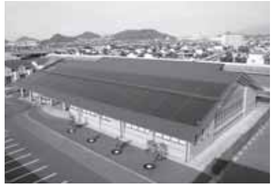
写真③ 屋根材一体型ソーラーシステム:950㎡の面積は、近隣市町村では見られない大規模なものです。
