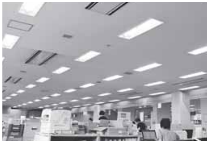
写真② 省エネタイプの照明:リサイクルのHf蛍光ランプを使用。
