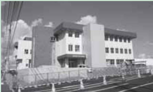
改修工事中の中央公民館
